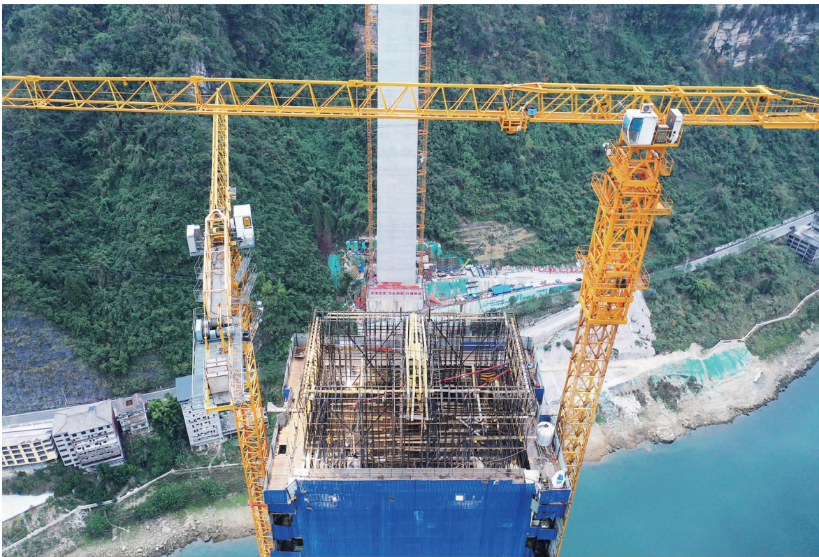
亚洲第一高墩矮塔斜拉桥 3 号主墩 216 米顺利封顶。
