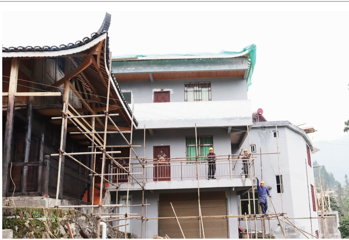
近日,在胡家湾传统村落整治建设现场,工人们正在忙着施工。胡家湾传统村落整治项目属于绍庆街道阿依河社区乡村振兴农村人居环境整治项目的一期工程,此次建设着重对其建筑、宅院、公共空间等进行改造,进一步加大对传统村落的保护力度,着力突出特色,确保真正维护好、运营好传统苗寨村落。
