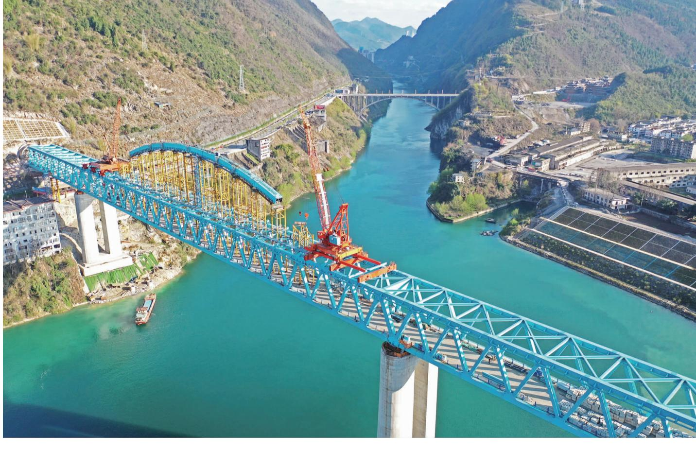
3月13日,工人们正在加快渝湘高铁清水坪乌江大桥的钢拱肋架设。清水坪乌江大桥由中铁大桥局承建,是渝湘高铁重庆至黔江段“六隧五桥”之一。大桥全长804.6米,主跨240米,一跨过江,为国内首座双Y型单拱肋主拱结构无砟轨道高速铁路桥梁。渝湘高铁重庆至黔江段是国家规划“八纵八横”高铁网中厦渝通道的重要组成部分,是重庆“米”字形高铁网中东南向高铁通道。建成通车后,重庆市中心城区到黔江区的通行时间将从现在的4个小时缩短至1个小时以内,沿线将形成一条黄金旅游线,届时将填补渝东南武陵山区城镇群高铁空白,对促进沿线旅游资源转化为经济资源,提升重庆对周边地区辐射带动作用具有积极意义。
