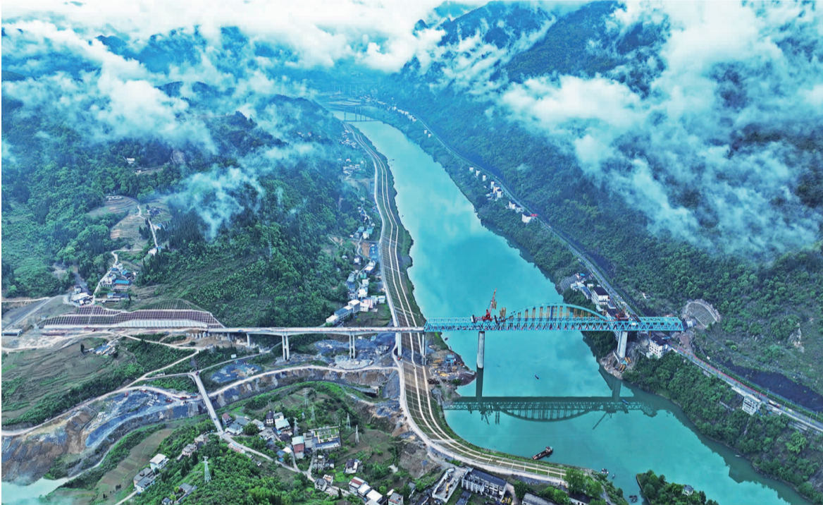
4月27日,位于汉葭街道境内的渝湘高铁清水坪大桥建设现场,晨雾笼罩下的群山与初见雏形的高铁桥梁构成一幅壮美的画卷。
